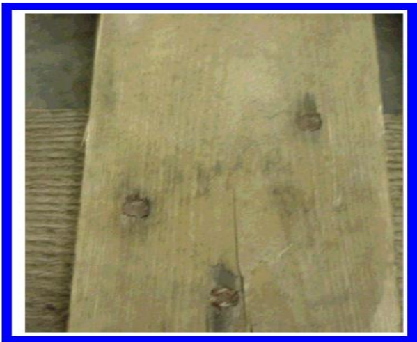
Гвозди полностью утоплены в доски (не выступают)
